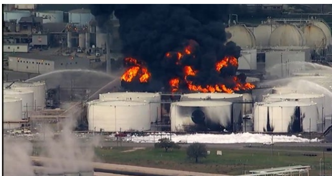
ITCs depåanläggning i Deer Park, Houston, U.S.A.
