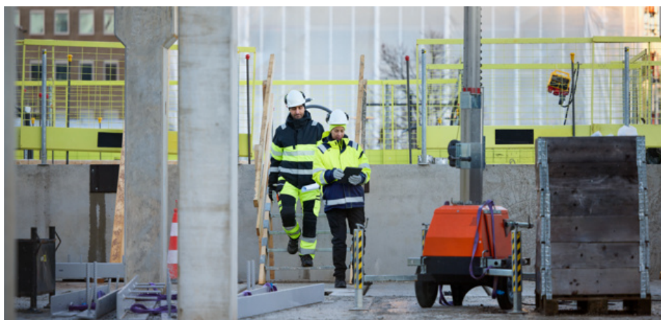
På exempelvis byggarbetsplatser är det viktigt att tänka på nedfallande föremål. Foto: Johnér bildbyrå/Anna Dillner.
