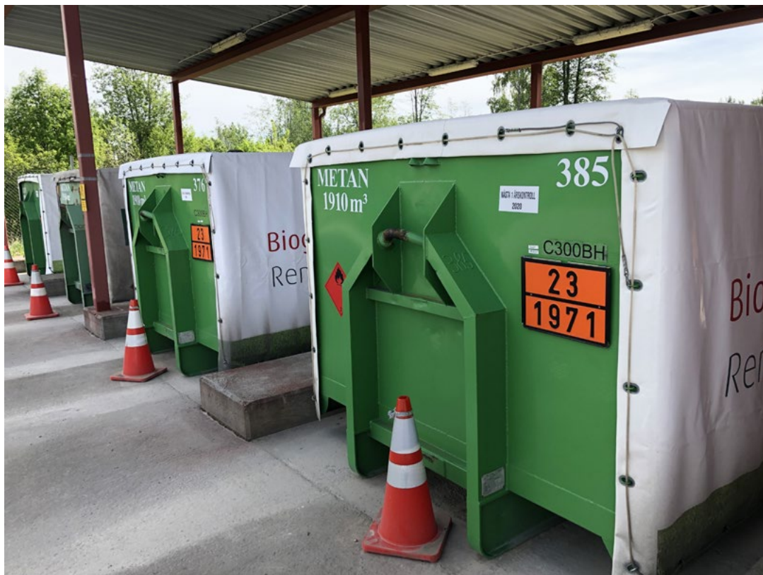
Figur 29. Mobila gaslager (MEG-containerar). Foto: David Gårsjö.
